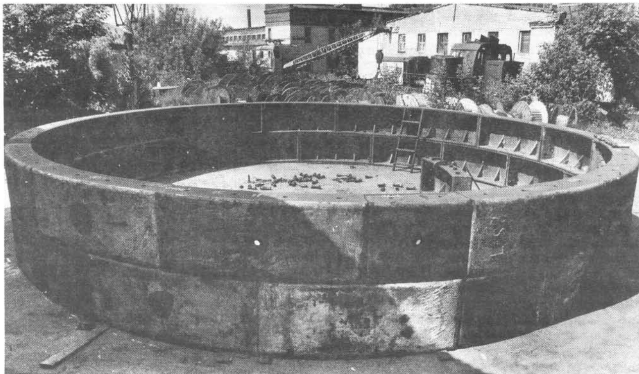
Новая тубинговая обделка диаметром 9,8 м, разработанная для эскалаторного тоннеля станции «Трубная».
