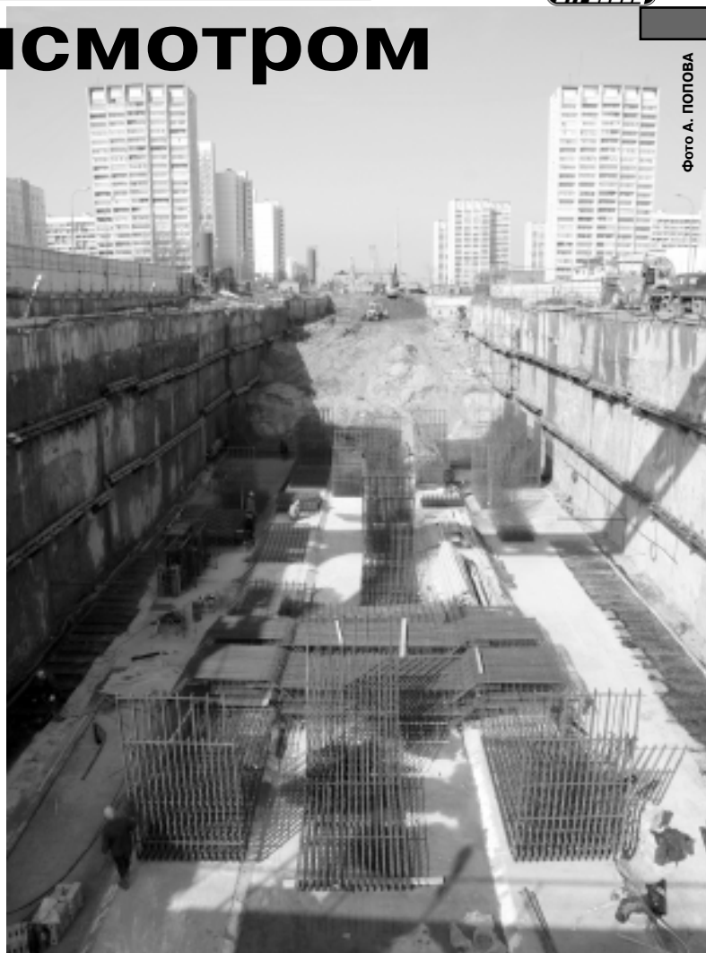
Котлован на Строгинском бульваре продвигается в сторону МКАД.
