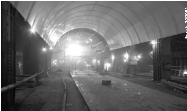
На станции «Трубная площадь» идут отделочные работы.
