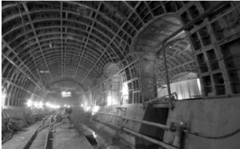
Строящаяся станция «Сретенский бульвар».
