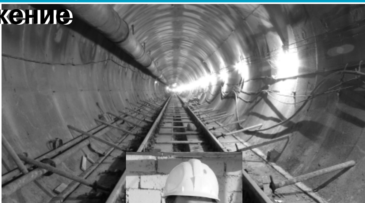
Отрезок левого тоннеля с уложенным путевым бетоном и частью коммуникаций.
