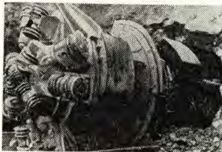
Рис. 2. Тоннельно-проходческая машина фирмы «Демаг».
