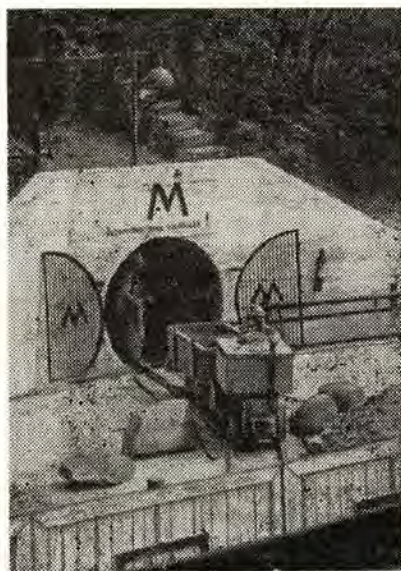
Противооползневая галерея, сооружаемая ТО № 4 Киевметростроя в Черновцах.
