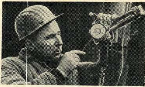
Рис. 2. Электрик С. Стовпник (СМУ-5) заправляет гидроизоляционный шнур в электросварочный инструмент.
