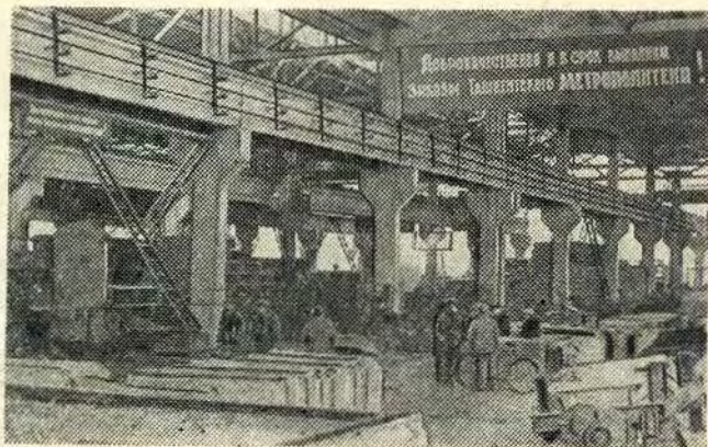
В цехе завода железобетонных конструкций
