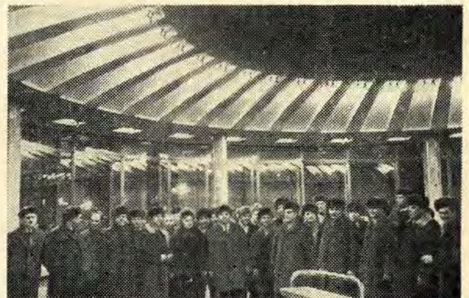
Строители ст. «Улица 1905 года» в вестибюле станции
