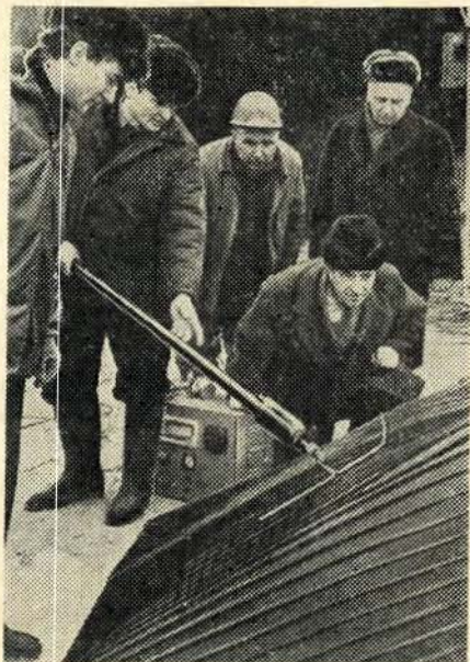
Рис. 3. Метростроители М. Баженов, А. Чача, С. Стовпник, С. Горелов, С. Кнзиков наблюдают за работой инструмента, способного обнаружить дефекты в изоляции.
