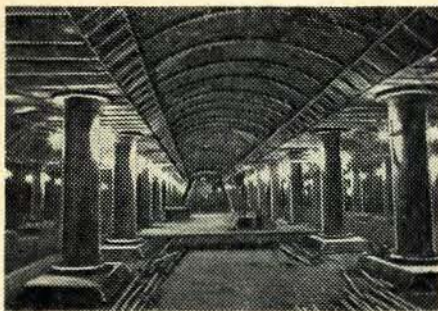
Рис. 2. Гидроизоляция из металлических листов на ст. «Баттани».
