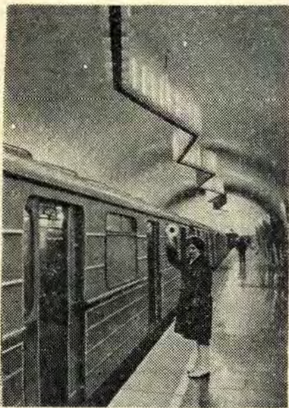
Путевой тоннель ст. «Баррикадная».
