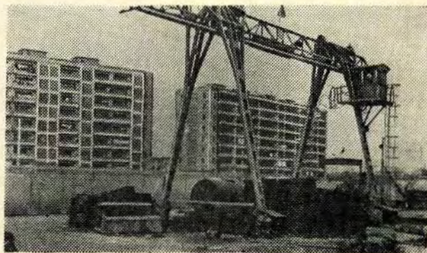
Строительная площадка ст. «Чиланзар»
