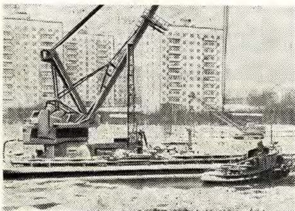
Опускание секций в русло канала плавучим краном
