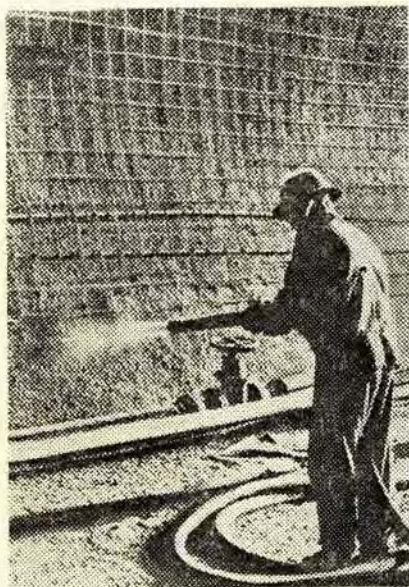
Нанесение шпринц-бетона
