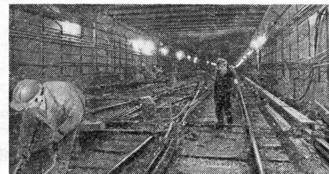
Путьцы на перекрестном съезде оборотных тупиков «Планерной»
