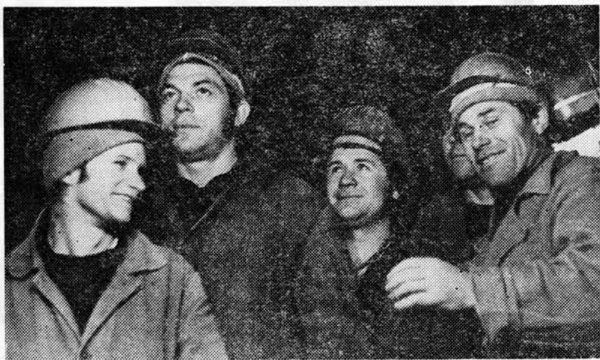
Бригада И. Немого (СМУ-5), соорудившая тоннель под каналом
