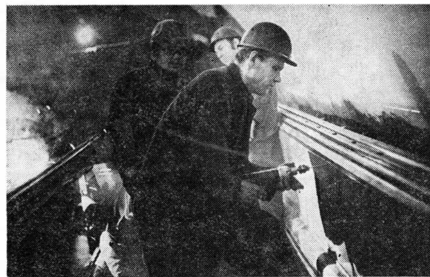
Завершающие работы на станции «Пушкинская». На снимке: бригадир монтажников В. Авдонин (СМУ-4)
