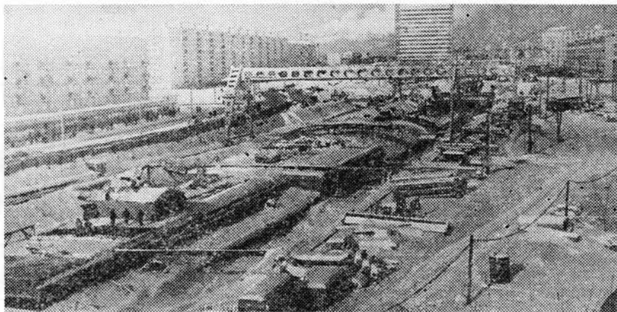
Рис. 4. Панорама строительства «Сходненской».
