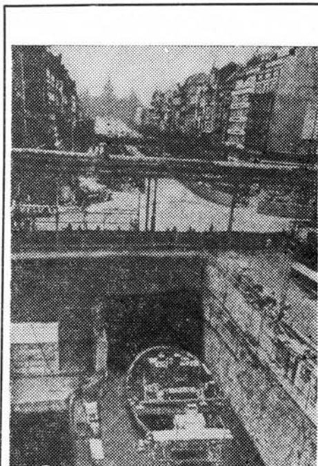
На строительстве новой линии Пражского метрополитена
