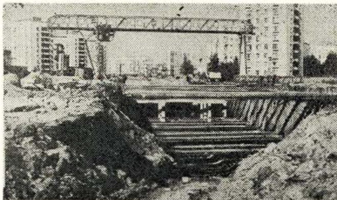
Возведение конечной станции Кировско-Выборгской линии «Проспект ветеранов».
