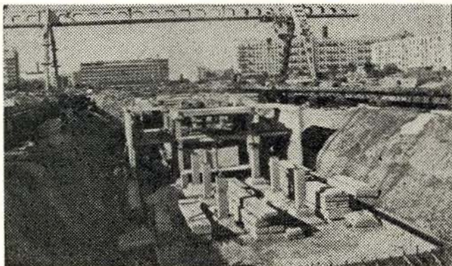
Сооружение вестибюля и СТП станции «Проспект Героев».
