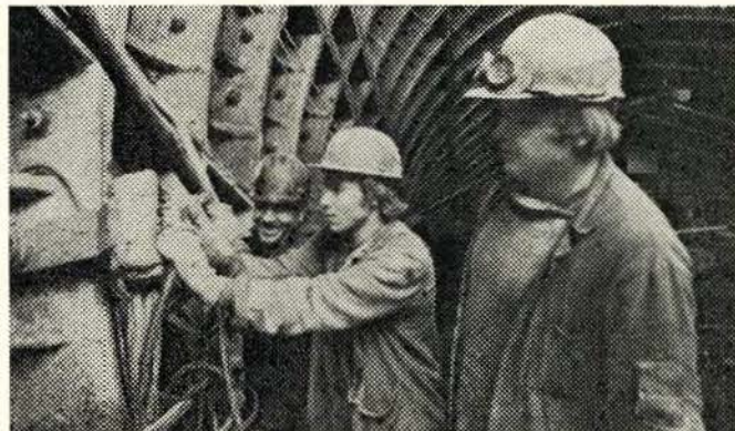
Проходчики П. Мироненко, П. Климец и бригадир Ю. Петрушин (СМУ-17) на строительстве наклонного тоннеля ст. «Гражданская».
