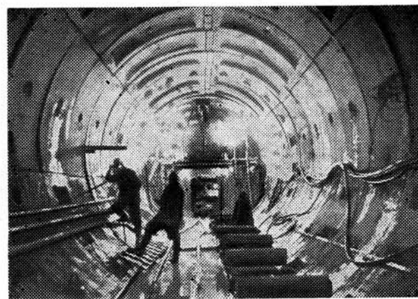
В левом перегонном тоннеле «Шоссе Энтузиастов» — «Перово»
