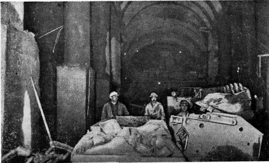
Вынуты последние кубометры породы на станции «Киевян»
