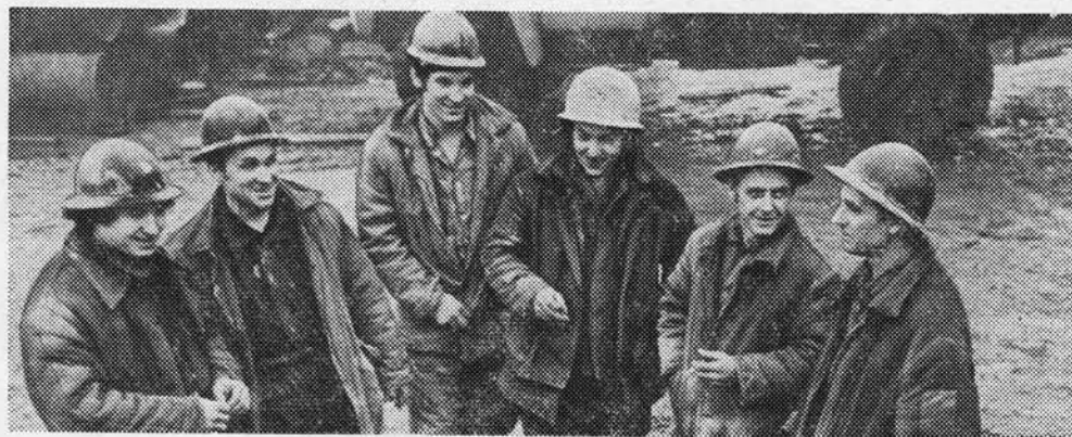
Передовая бригада СМУ-7, возглавляемая В. Найденовым, сооружала левый перегонный тоннель между станциями «Шоссе энтузиастов» и «Перово».
