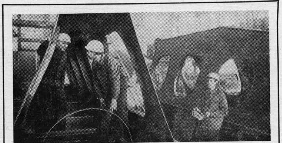
На снимке: слесари механического завода Главтоннельметростроя тт. В. Платонов, Б. Сазонов и А. Акимов за монтажом узлов крана ККТС-20 к механизированному комплексу.
