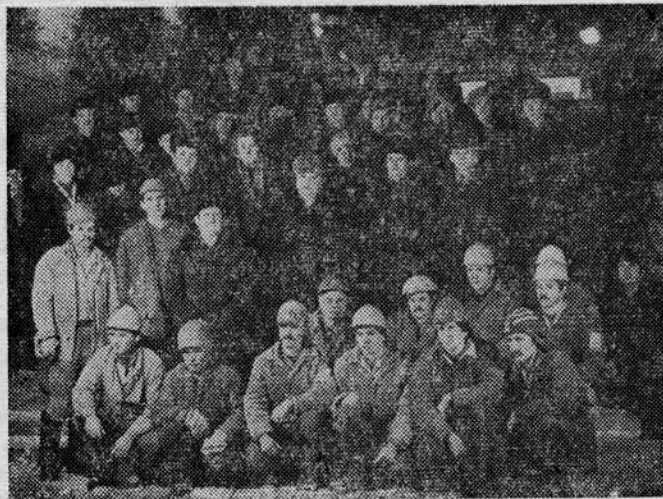
Митинг, посвященный укладке последнего блока новой сейсмостойкой станции «Айбек». На снимке: представители завода ЖБИ-2 и треста «Ташметрострой».
