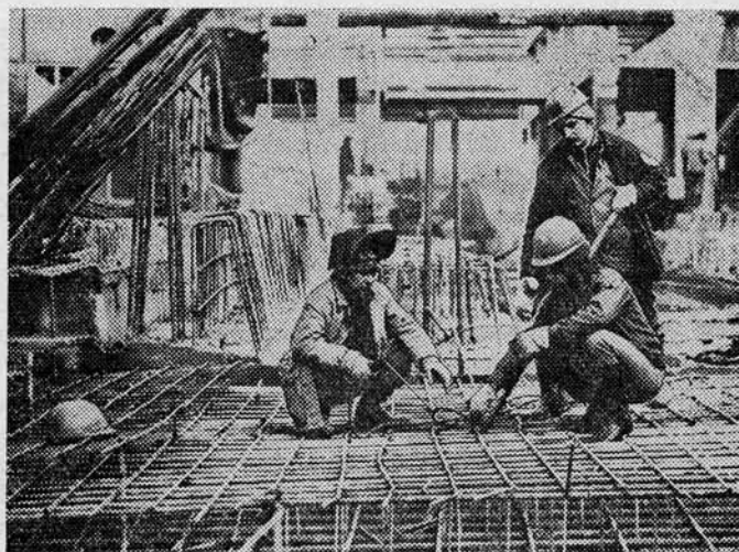
Армирование лотка СТП станции «Прспект космонавтов». Слева направо: сварщики С. Шарипджанов, В. Выгловский и проходчик В. Бондаренко (СМУ № 2).
