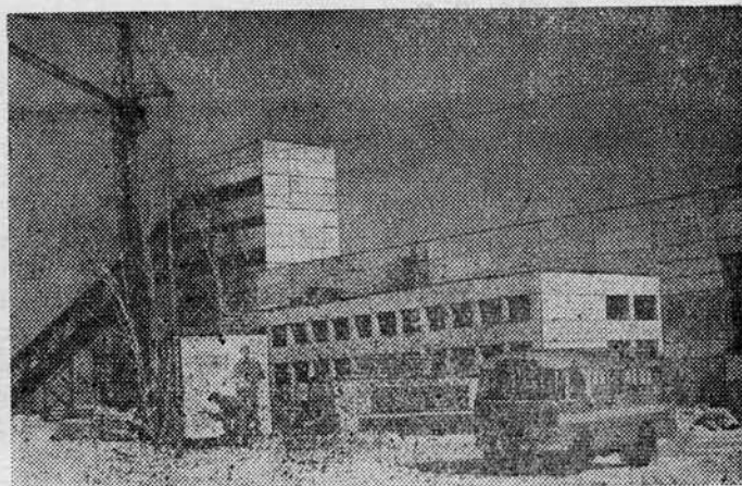
Строительство завода ЖБК
