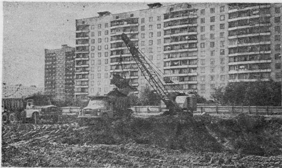
Первые кубометры грунта на месте будущей станции «Празжская» Московского метрополитена.
