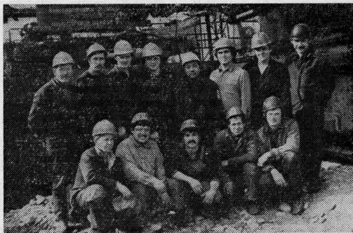
Комплексная бригада В. Шегая, осуществлявшая механизированную проходку тоннеля.
