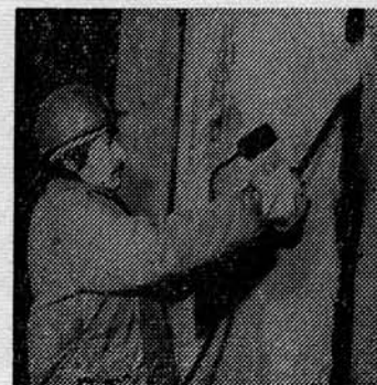
Оплавление и склеивание выпуклов гидроизоляции стыков секций обделки.
