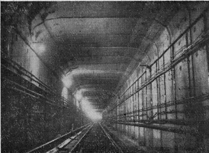
Перегонный тоннель «Тульская» — «Нагатинская».
