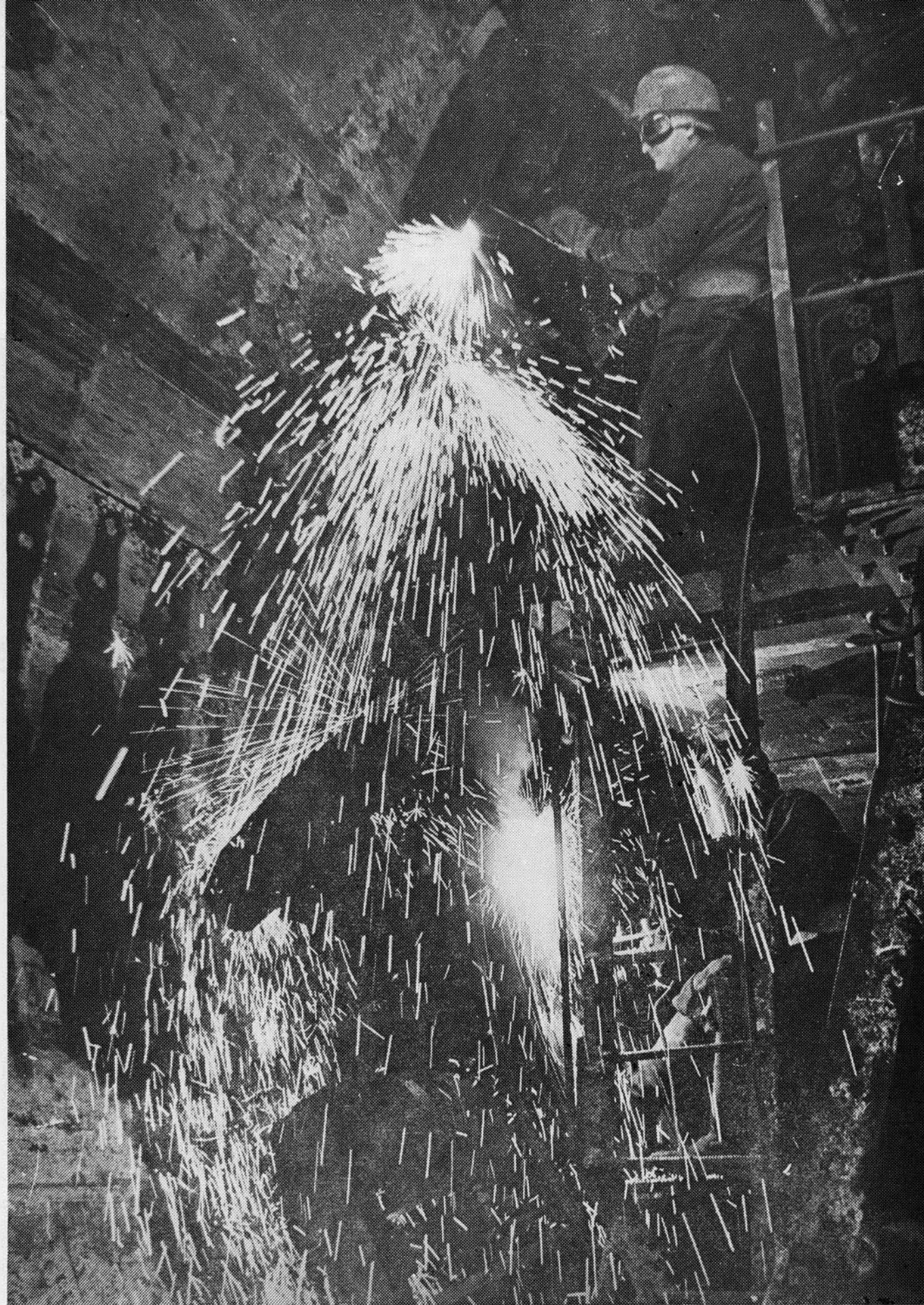
На строительстве Минского метрополитена. Подготовка к монтажу горнопроходческого комплекса для сооружения перегонного тоннеля участка II очереди.
