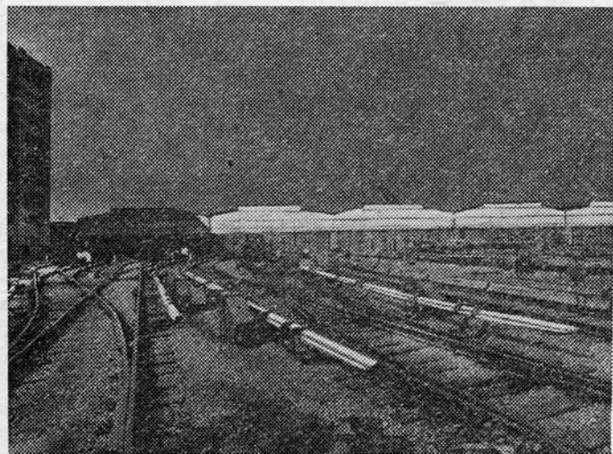
Из фотохроники строительства Серпуховской линии. Электродено.
