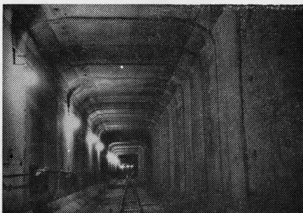
Перегонный тоннель «Ленино» — «Орехово».
