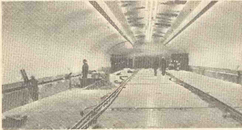
Станция «Чкаловская». Предпусковые «штрихи».
