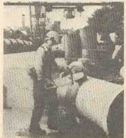
Рис. 9. Распиловка труб из керамики (бетона и каменных материалов) с помощью механизма, оснащенного алмазным диском.
