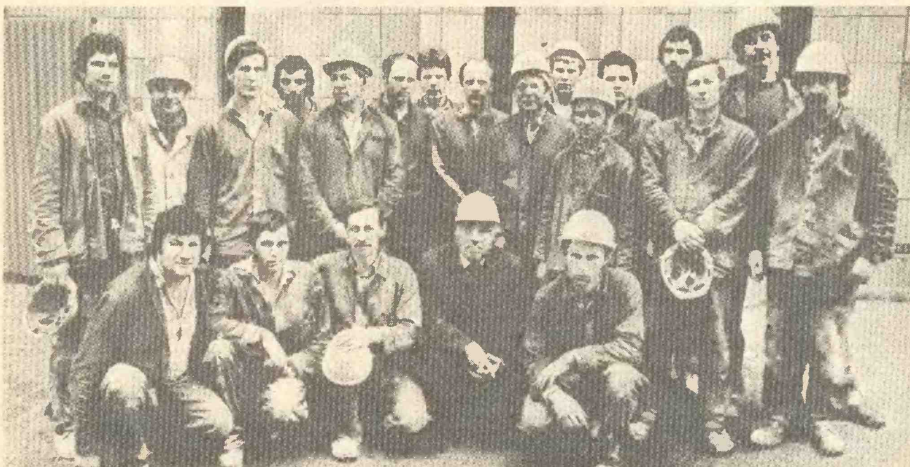
Интернациональная бригада, руководимая Е. Мартыновым, выполнила отделочные работы на станции «Московская» в Праге.
