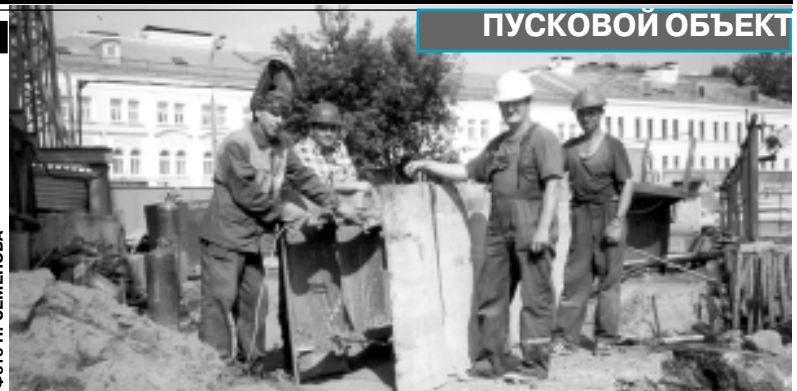
Участок В.М. Иванова из СМУ-9 готовит пионерную траншею для «Касагранде». Слева направо: электросварщик Н.Ю. Жук, звеньевой И.С. Спильниченко, горный мастер А.Е. Огородников и бетонщик Н.И. Ершов.
