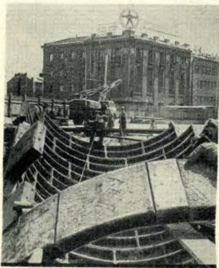
На площади Тевелева к ст. «Центр» проложен эскалаторный тоннель.
