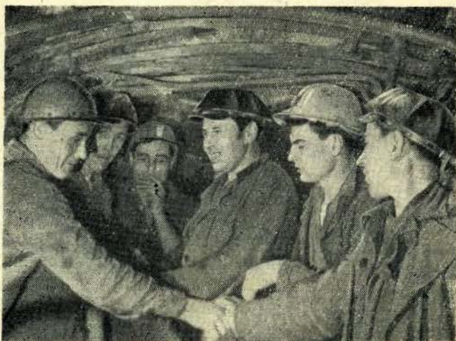
Первая сбойка. Проходчики приветствуют друг друга в верхней ячейке щита. В центре бригады проходчиков Н. Симяков и А. Кобозев, соорудившие ранее тоннели Абакан-Тайшета и Вахи-Явана.
