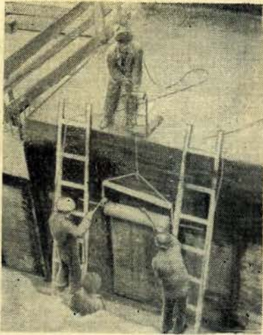
Рис. 2. Звено из трех человек наклеивает рулонный материал на стены с применением лебедки.
