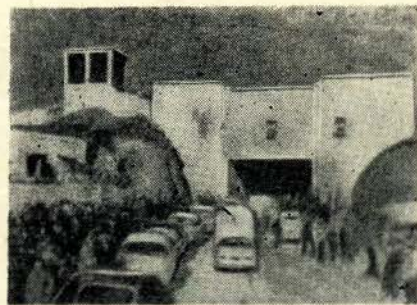
Портал тоннеля под Пушкинским перевалом.
