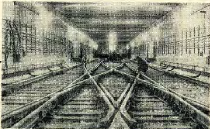
Трасса новой линии Киевского метрополитена «Завод Большевик»—«Святошино» в эксплуатации. На снимках: камера съездов и тоннели, сооруженные открытым способом.
