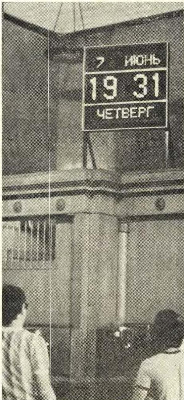
В кассовом зале вестибюля станции «Площадь революции» московского метрополитена в опытный порядок установлены электронные часы-календарь. Пассажиры теперь имеют возможность видеть не только цифровое обозначение московского времени, но и день недели, число, месяц. Принцип работы часов бесконтактный, с применением полупроводников.
