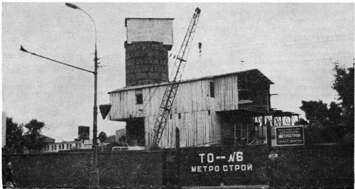
Монтаж горного комплекса
