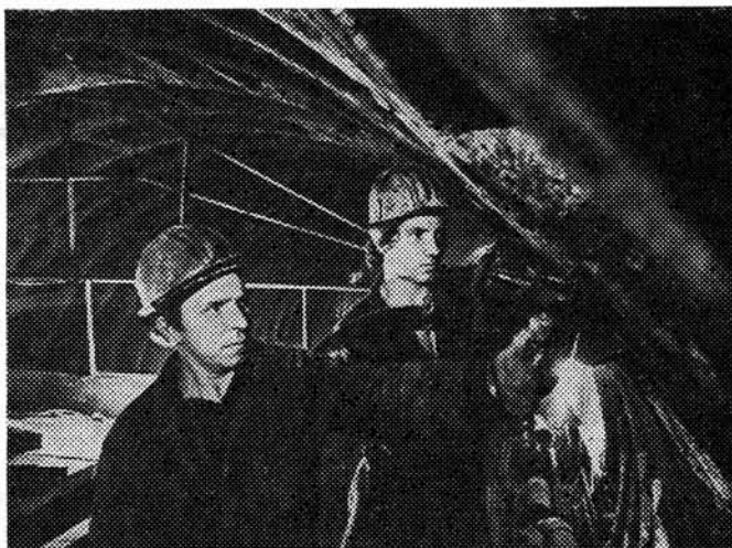
Изоляционные работы в центральном зале ведут А. Гулкин (слева) и Г. Силецкий (СМУ-7 Мосметрострой)
