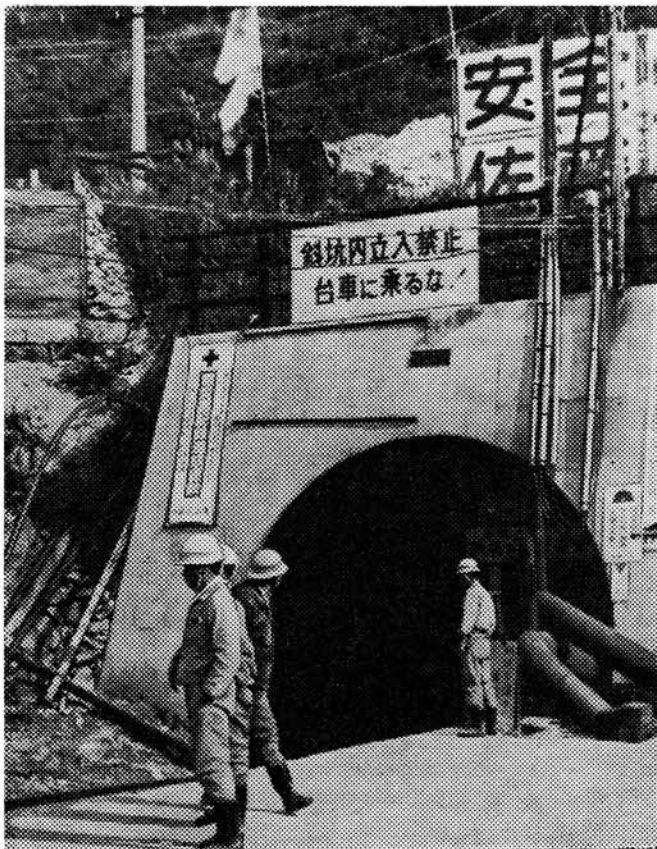
Портал вспомогательного наклонного ствола.
