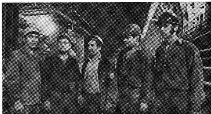
Комплексная бригада И. Шепелева, сооружающая станцию «Марксистская».
