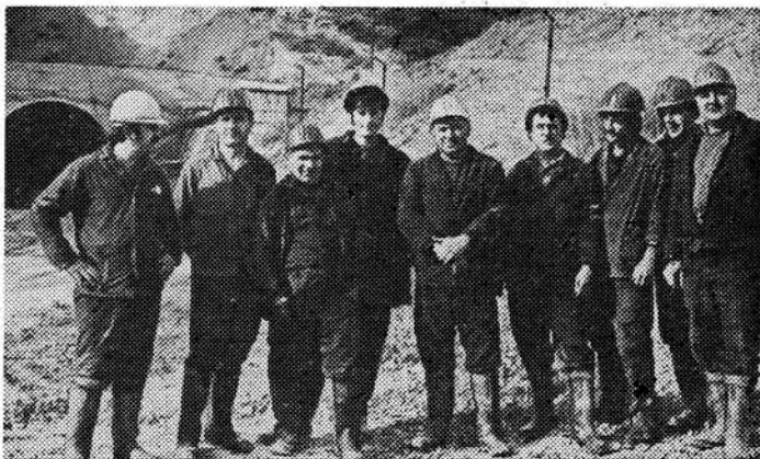
Строители восточного портала Мухометского железнодорожного тоннеля.
