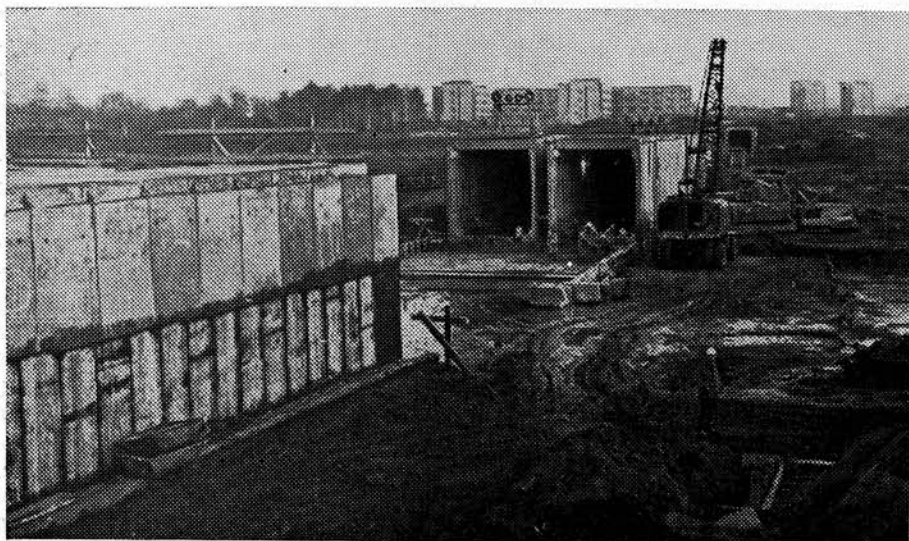
Участки строительства перегонных тоннелей
