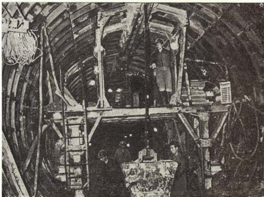
Технологическая тележка проходческого щита, с которой производится первичное нагнетание раствора за обделку и чеканка швов
